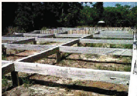
การก่อสร้างได้ทำการตอกเสาเข็มและยกคานพื้นฐาน มีความคืบหน้าประมาณ 20 %
