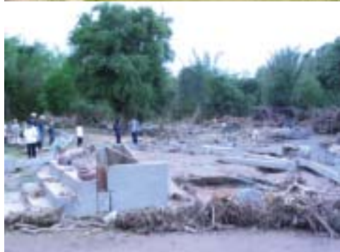
บ้านแม่ชั้นคำ ก่อน-หลังน้ำท่วม
